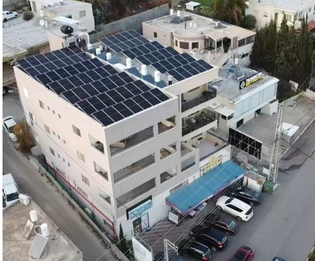
תרשים 37. מערכת סולארית על גג בניין ברח' אליאסמין בדאלית אל כרמל; השימוש בלוחות לאגירת אנרגיה סולארית הולך ומתרחב בהדרגה
